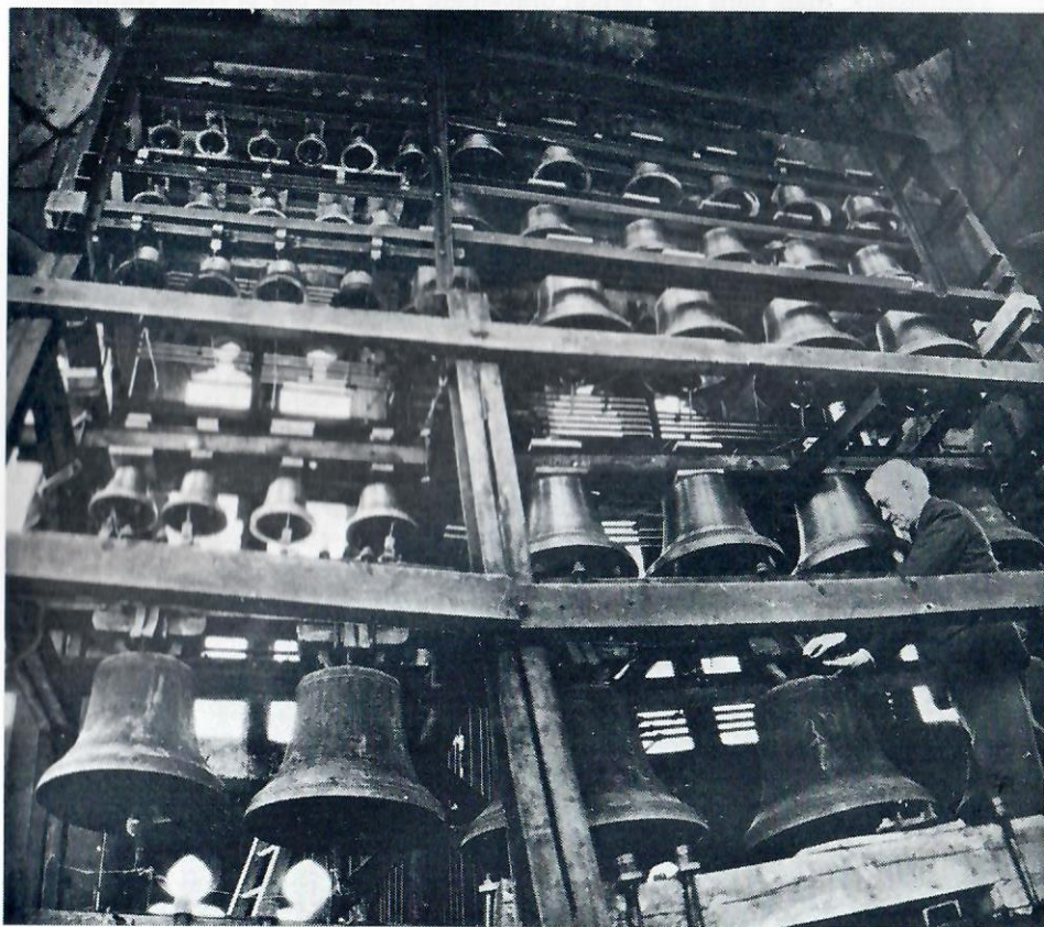
Le carillon de 50 cloches de la cathédrale de Rouen, fondu et installé par Paccard en 1954
