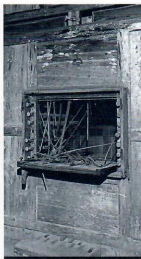
État de la console avant les travaux. Photo : Hervé Caill.
